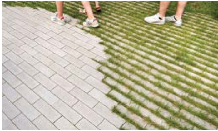
1 betonová dlažba menšího formátu hra se šířkou zatravněné spáry plynulé prolnutí do okolního trávniku
